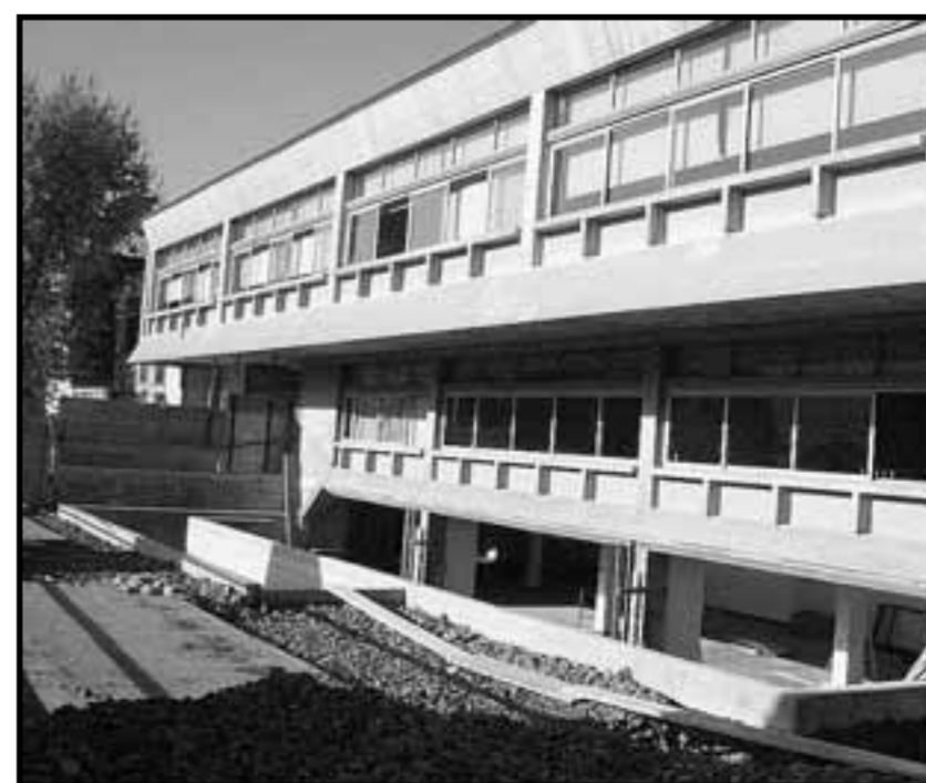
Lavori in corso alle medie di Desenzano e Comenduno
